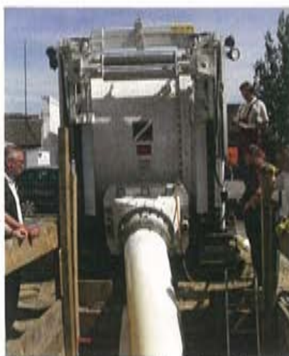
Abb. 9 Drucktrommel bei der Schlauchreversion an der Startgrube (Baugrube 5) von Abschnitt 2.
