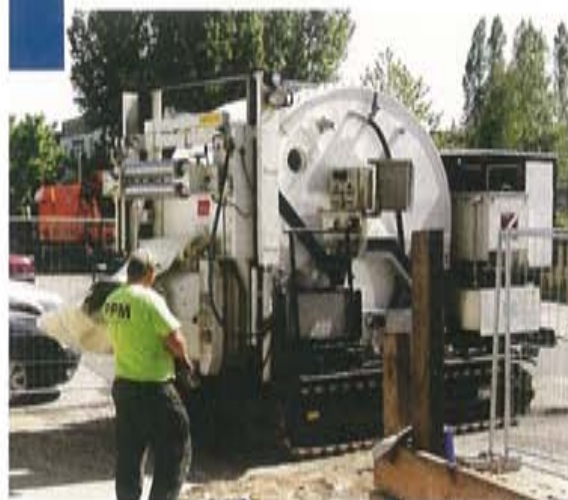
Abb. 8 Positionierung der selbstfahrenden Drucktrommel auf gummibewehrtem Raupenfahrwerk an der Startgrube (Baugrube 5)
