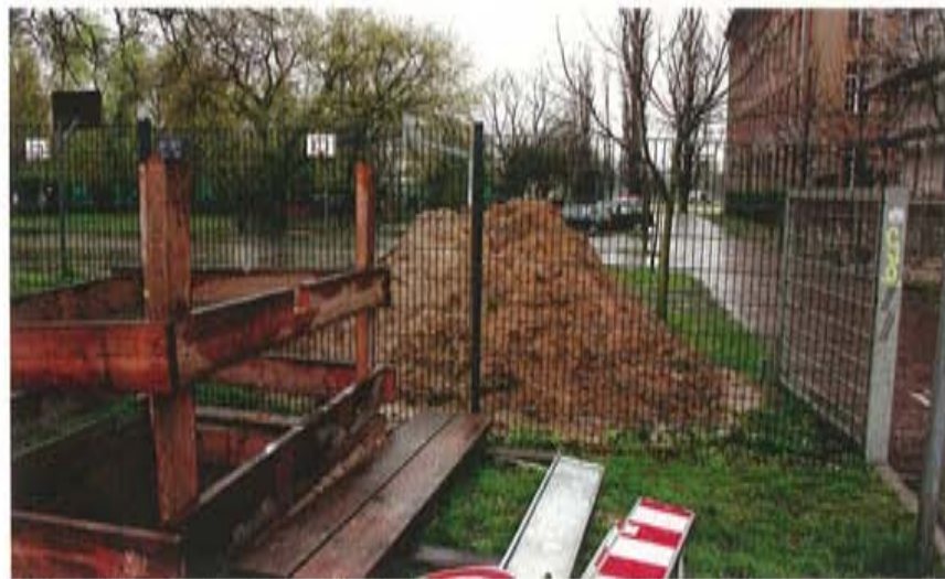
Abb. 7 Kleine Zielgrube des Abschnitts 1 an der Modersohnstraße (Baugrube 1)
