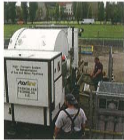
Abb. 6 Gewebeschlauchreversion von Baugrube 3 in Richtung Baugrube 1 auf einer Länge von 303 Metern. Dabei werden zwei Sportplätze und ein Schulhof unterquert.
