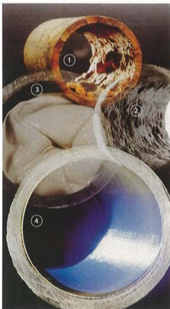
Abb. 1 (1) Ausgangssituation in krusiertes und lokal geschwächtes Trinkwasserrohr, (2) mittels Sandstrahlen gereinigtes Graugussrohr, (3) Reversion des klebstoffgefüllten Gewebeschlauchs, (4) längsfaltenfrei und bruchsicher ausgekleidetes Rohr
