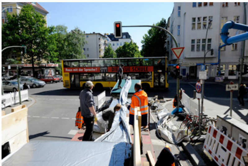
Die Baustelle in der Düsseldorfer Straße
